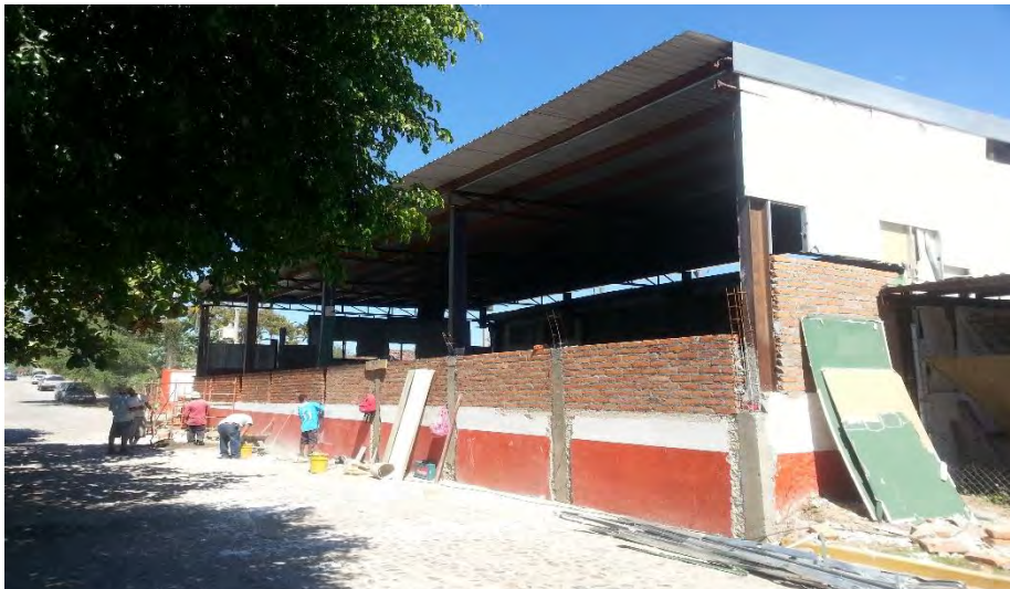
Trabajos de construcción para área de box.
