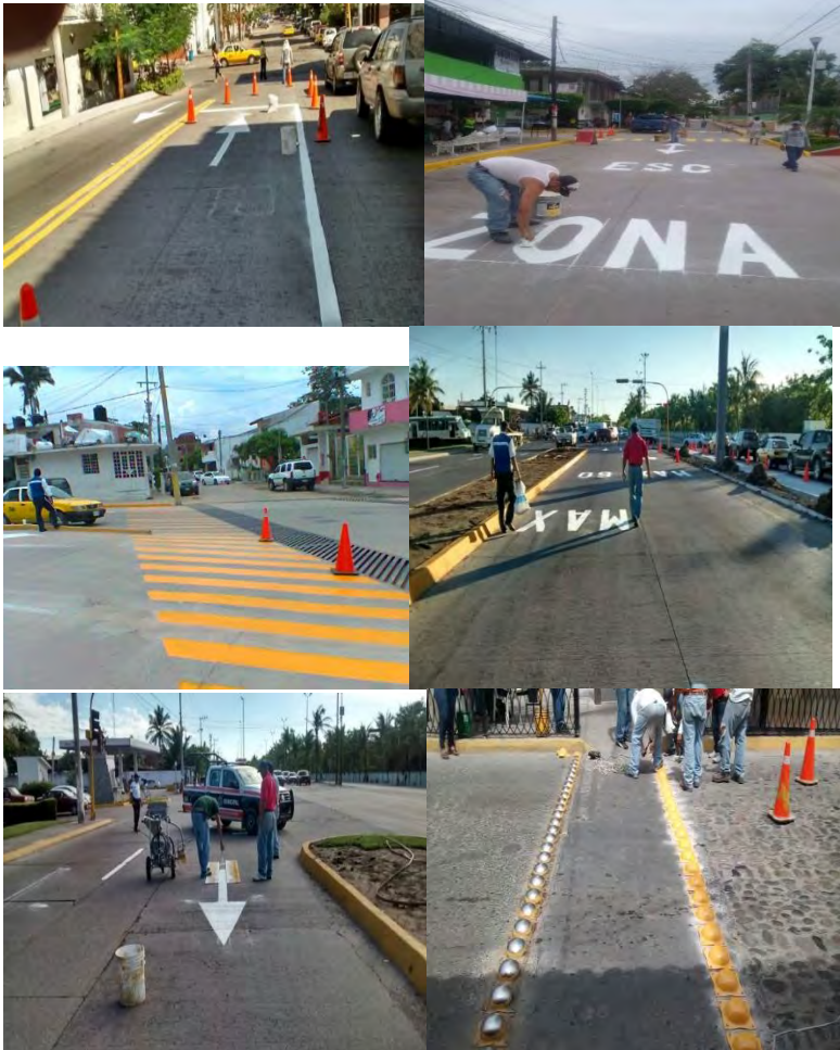
Trabajos de Balizamiento y Semáforos
